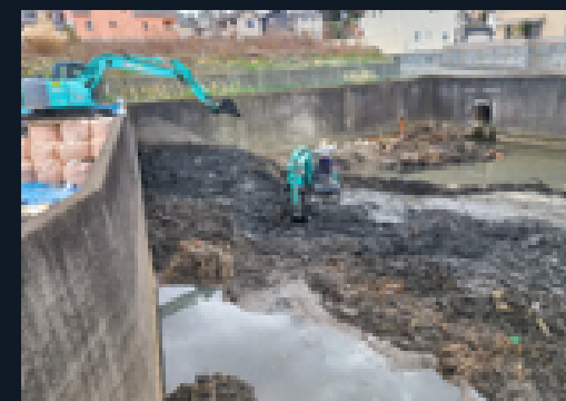
遊水池浚渫工事
