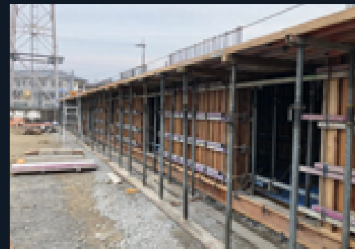
運動場倉庫工事
