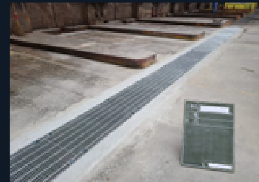
プラットフォーム排水溝修繕
