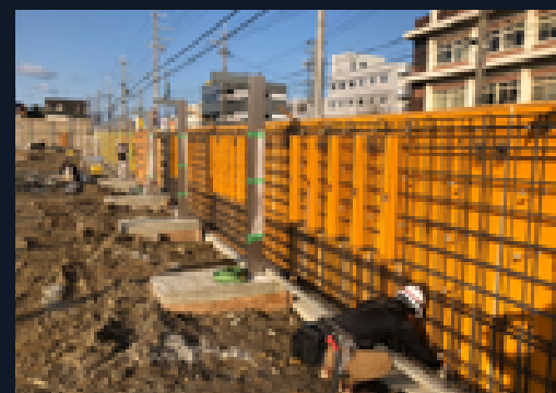
中学校 塀工事
