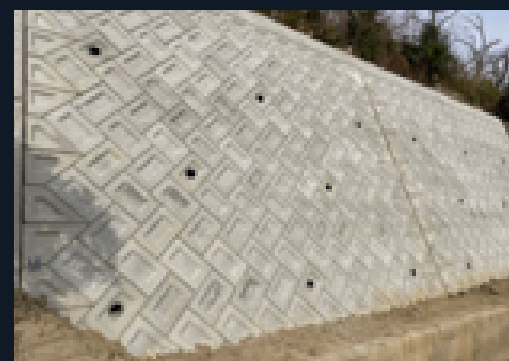
法面間知擁壁工事
