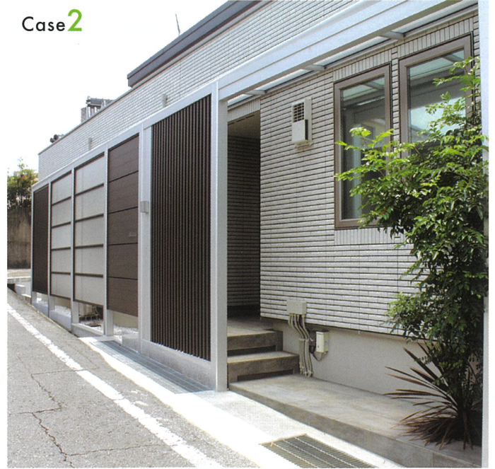
Case 2 M. グローリアを採用し、玄関前の空間を有効活用。
